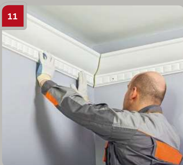
11 Couper l'élément suivant. Vérifier l'alignement des corniches. Recommencer la coupe le cas échéant.
