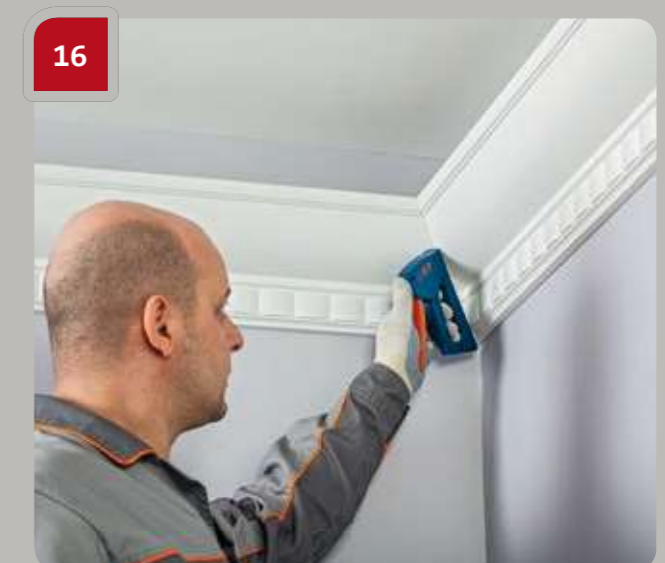
16 Fixer la zone de joint avec une agrafeuse de chantier.
