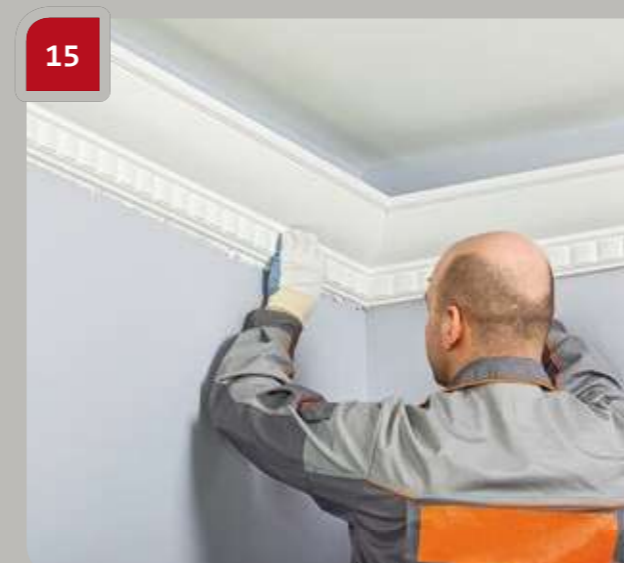
15 Appuyer la corniche sur le mur et le plafond jusqu'à ce que la colle ressorte tout le long du joint. Déplacer le produit le long du mur en appuyant sur la corniche adjacente jusqu'à ce que la colle sorte du joint.
