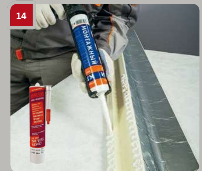
14 Appliquer de la colle G10U290 ou G06M290 sur la surface de la corniche suivante.
