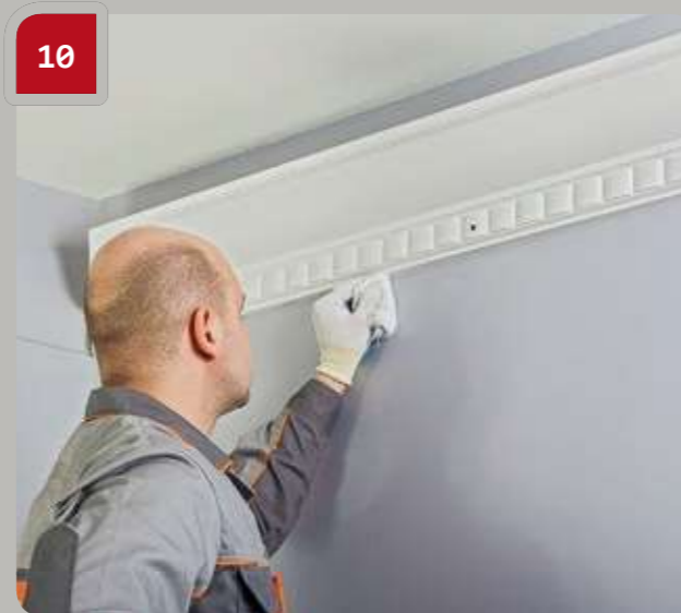
10 Avec la colle Assembly, retirer l'excès en essuyant les zones avec un chiffon imbibé d'eau ; utiliser de l'acétone si de la colle Multipurpose est employée.
