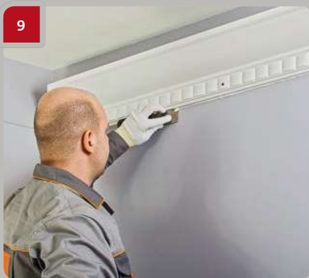
9 Retirer l'excès de colle avec une spatule immédiatement après avoir mis les vis auto-foreuses.
