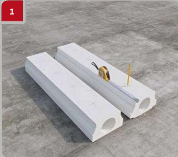
Faire des marques au crayon à la rampe et au rail du bas où les rails de guidage de la balustrade seront installés.
