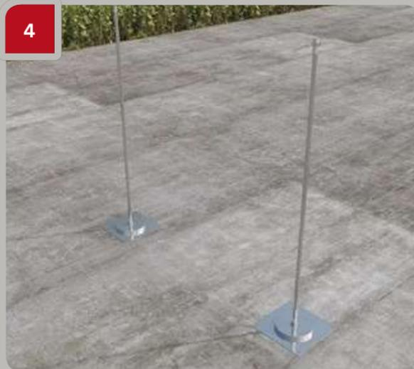
Fixer les flasques à la surface avec les boulons d'ancrage.
