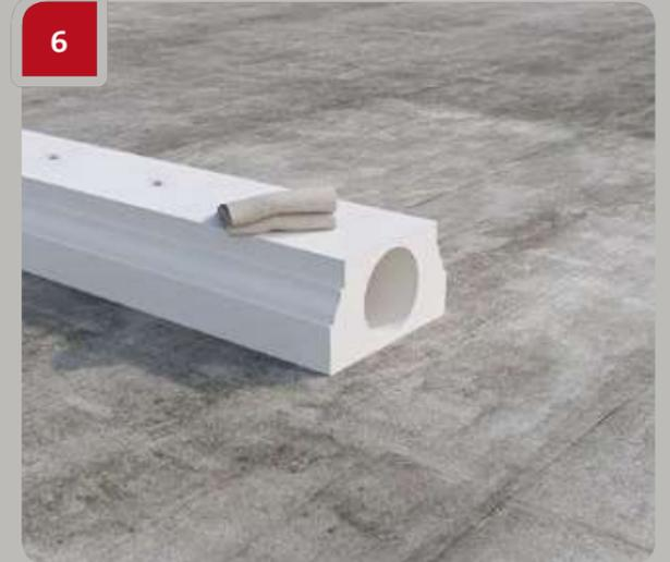
Nettoyer la poussière et la saleté des extrémités des éléments à joindre avec un chiffon mouillé.
