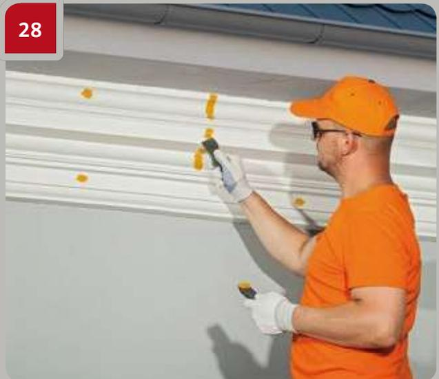
Appliquer du mastic aux endroits traités et sur les vis, utiliser du mastic automobile.
