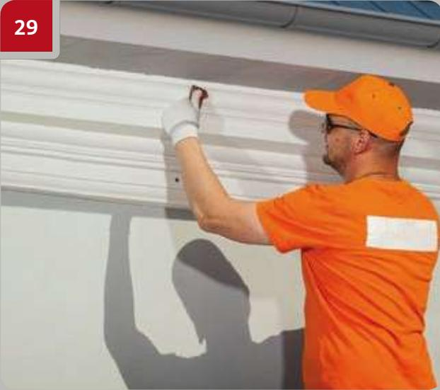
Quand le mastic a séché, polir les endroits traités et les trous de vis avec du papier abrasif fin. Le cas échéant, répéter l'étape 28.
