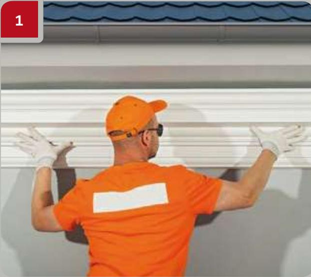
Fixer l'élément au point de montage. Appuyer fermement le produit au mur et au plafond, et marquer le mur le long du bas du produit.
