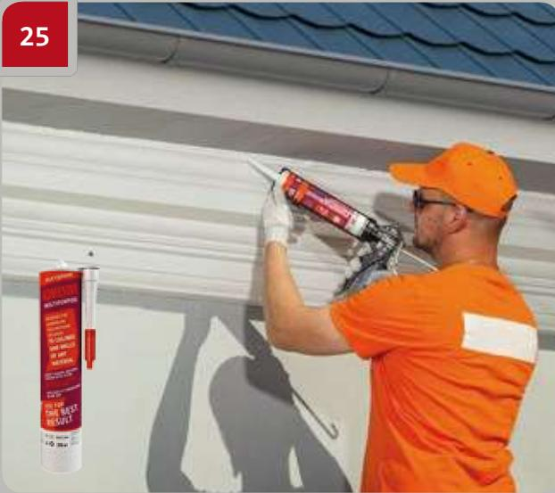
Aux endroits où un élément est en contact avec la surface et que la colle ne ressort pas du joint, remplir le vide avec plus de colle.
