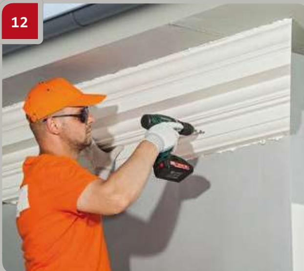
Utiliser une visseuse pour visser les têtes d'ancrage dans l'élément à une profondeur de 2 mm.
