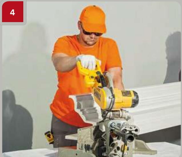
Avec une scie à onglet ajustée à l'angle approprié, faire une coupe dans l'élément.
