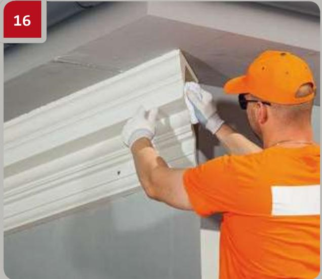
Utiliser un chiffon humide pour retirer la poussière et autres saletés de l'extrémité des éléments au joint.
