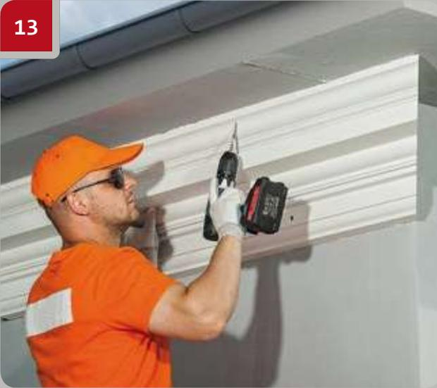
Avec la visseuse et une vis auto-foreuse, tenir la partie supérieure de l'élément et enfoncer la tête de vis à 2 mm de profondeur.
