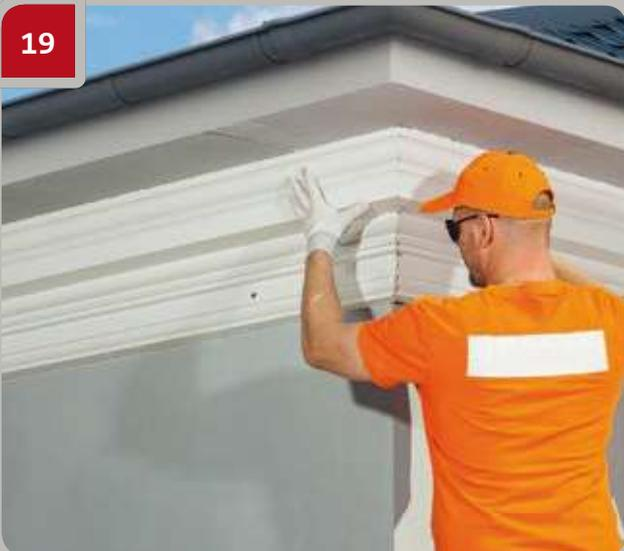
Fixer l'élément au point de montage. Appuyer suffisamment fort sur toute la longueur de l'élément pour faire ressortir la colle du joint. Glisser l'élément le long du mur en appuyant contre l'élément adjacent pour que la colle ressorte du joint.
