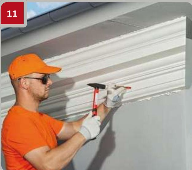
Fixer l'élément en place avec les ancrages à impact.
