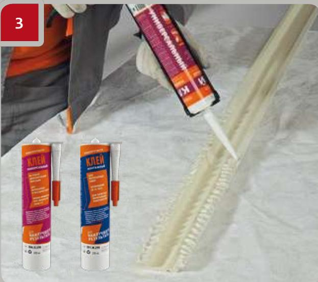
Appliquer la colle G06M290 sur la surface de montage (uniquement sur la zone de jonction avec le mur) ou G10U290 tout le long du produit. L'épaisseur de la couche de colle appliquée doit être de 3 à 5 mm.
