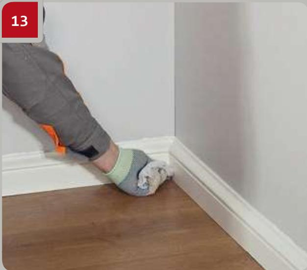
Essuyer la zone du joint avec un chiffon mouillé à l'acétone.
