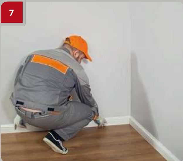
Couper l'élément suivant. Vérifier la forme du joint et le profil du produit, le cas échéant, recouper.
