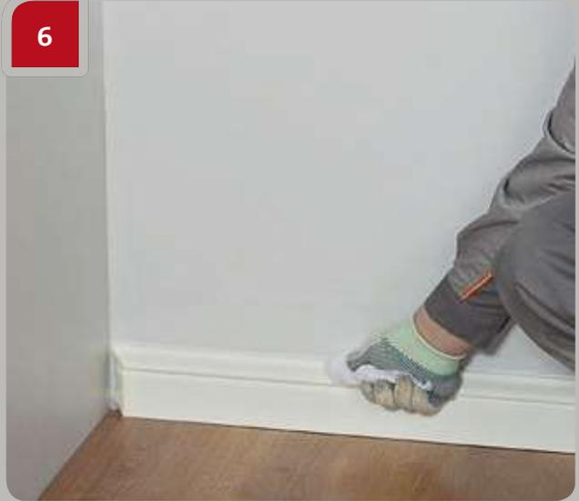
Le cas échéant, essuyer la jonction entre le produit et le mur avec un chiffon imbibé d'eau si vous utilisez la colle G06M290; avec de l'acétone si c'est de la colle G10U290.
